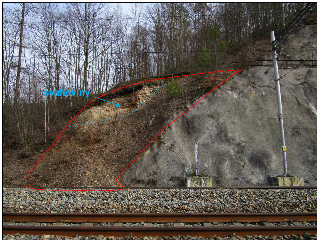
Obr. č. 5 – konec obkladní zdi v km 169,965, obkladní zeď - stříkaný beton by bylo vhodné rozšířit i na nezakrytý svah vlevo – označený červenou čarou, svahoviny předtím částečně odtěžit
