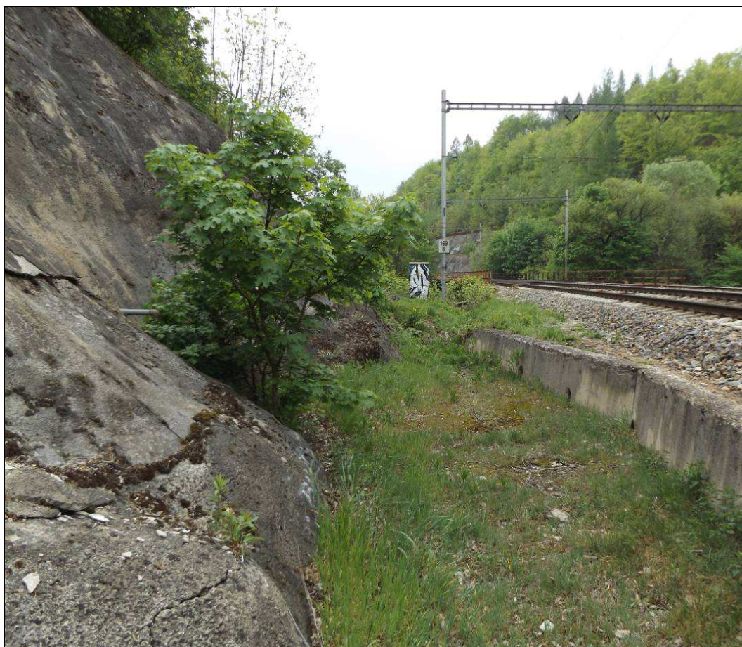
Obr. č. 3 – příkop vedoucí mezi patou ObZ a betonovu zídkou s ocelovými odvodňovacími trubkami
